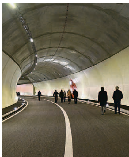
Der neue Hausmatttunnel. BKO
